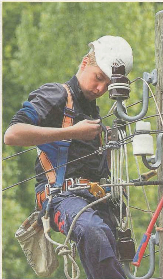
L'électricien de réseau a des tâches variées, mais il ne doit pas avoir le vertige. FÉLIX IMHOF
